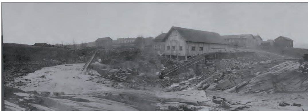
Saga og «kjerraten» nedenfor Hagafossen. I bakgrunnen til venstre ses våningshusene og en av lagerbygningene. Bildet er tatt i 1890-åra.
