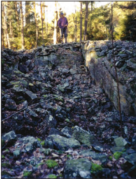
Oddvar Bergsland ser ned i et av dekningsrommene i november 2001. Trestokkene i taket hadde et tykt lag av gråstein på toppen. Stokkene har råtnet opp og det hele har falt sammen. Foto og eier av bildet: Finn Aarum
